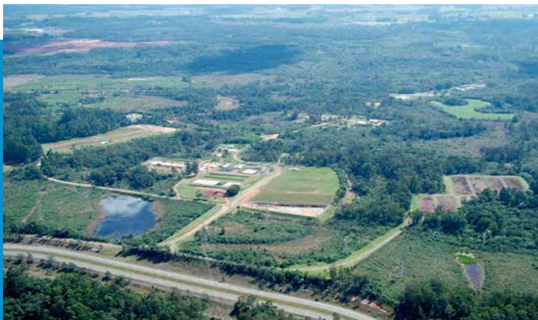
Vista aérea do SICECORS dentro do complexo industrial.
